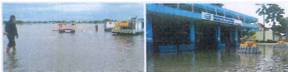
図 3-15 2021 年洪水時の溢水箇所 (Keshaliya 川)
