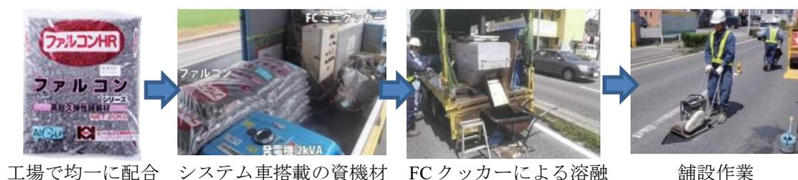
図 2 ファルコンの施工の概要
