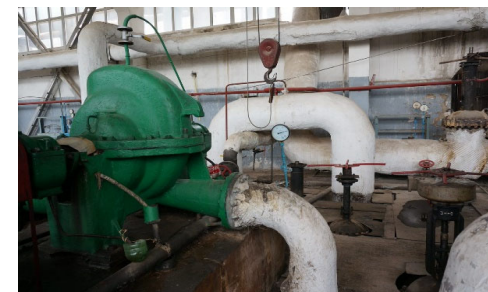
Сетевой насос и ручной регулирующий клапан расхода (ТЦ-8, Ташкент)
