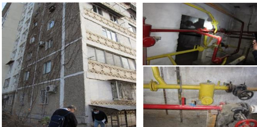
Рис. 22 Трубы теплоснабжения (подача и обратка) в тепловом пункте на цокольном этаже 9-этажного жилого дома
