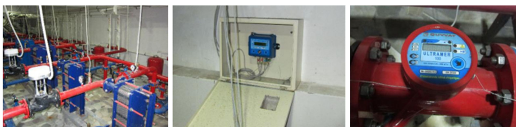
Рис. 16 Узел приема горячей воды закрытой системы, устройство считывания показаний тепловой энергии, прибор учета тепла в общеобразовательной школе
