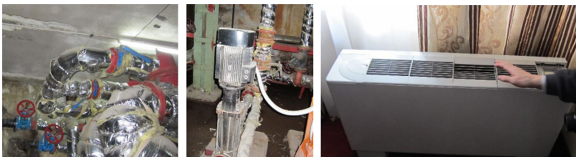
Рис. 17 Тепловой пункт, бустерный насос, фанкойл в гостинице
