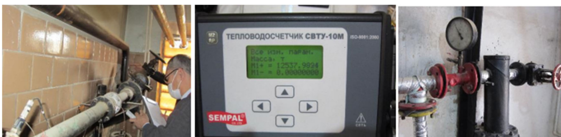
Рис. 15 Учет тепла (термометр) в больнице, устройство считывания показаний тепловой энергии, простая теплоизоляция
