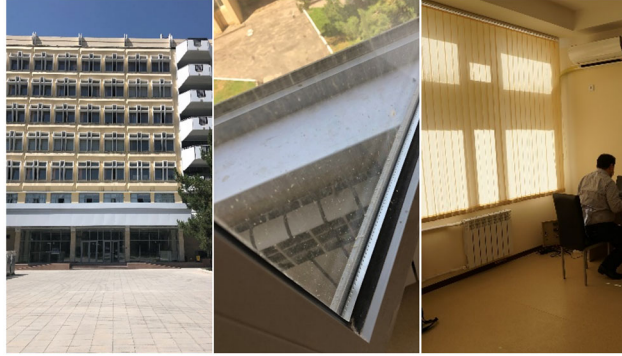
Рисунок 3-5 Внешний вид здания (слева), оконное стекло (в центре), интерьер (справа) Источник: исследовательская группа JICA
