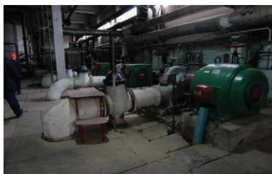
タシケント市 No1 地域熱供給所の返送水ポンプと配管の断熱施工
