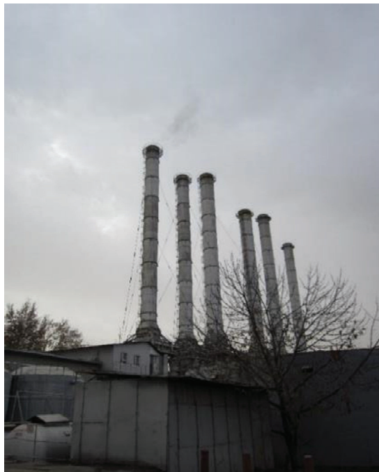
タシケント市 No1 地域熱供給所の煙突で観察された燃焼排ガス(水蒸気以外の排出)の実態
