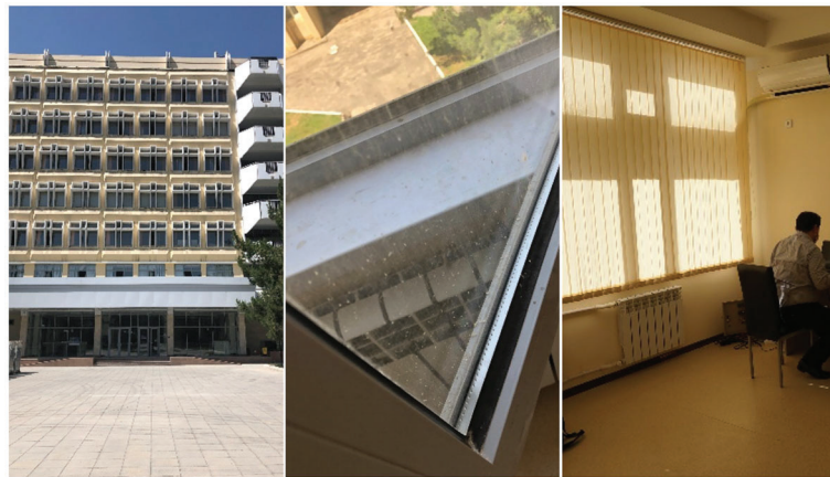
図 3-5 建物の外観(左)、窓ガラス(中央)、室内(右)の様子
