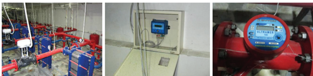
図 16 小中学校のクローズドシステム温水受入設備、熱量検針装置、熱量計
