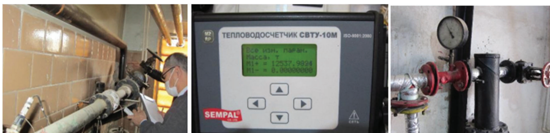
図 15 病院の熱量計測（温度計）、熱量検針装置、簡易断熱
