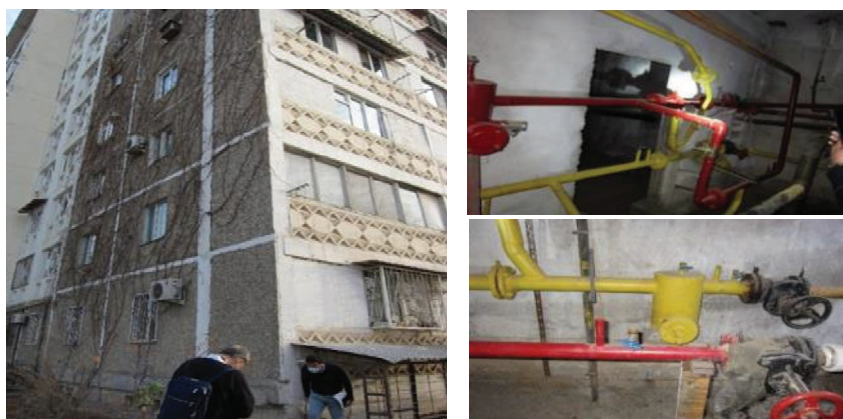
図 22 9階建て集合住宅の地下階にある受熱設備の温水配管と返送水配管
