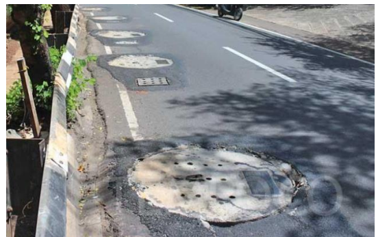
図4 車道への浸透井戸の設置の様子
