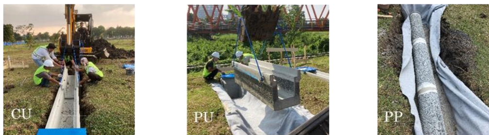
図 12 設置横断図と施工状況
