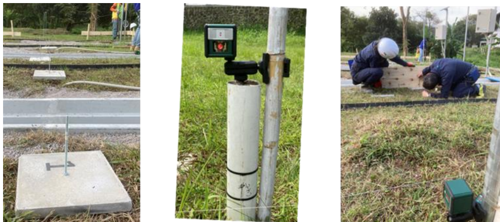
図 19 レーザーレベル計による沈下版の測定状況
