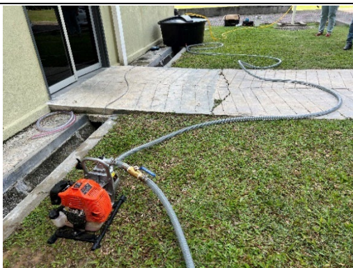
機材 (タンク,ポンプ,ホース) (2022 年 9 月)
