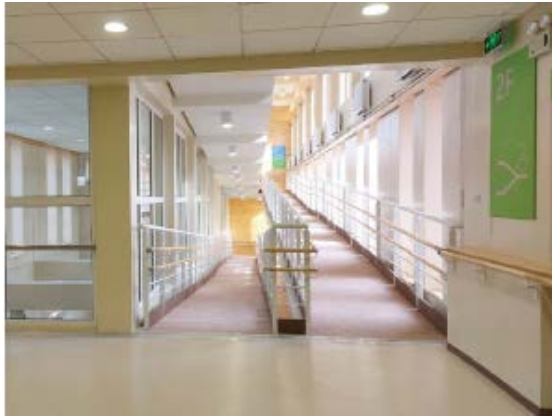
各階をアクセスフリーで繋ぐなだらかな勾配のスロープ
