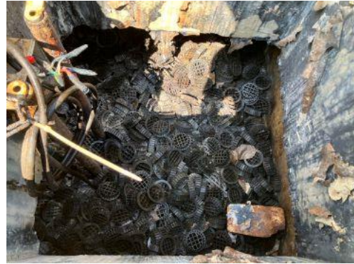
写真1 ローイェットタワーに設置された浄化槽 (円形のろ材が本来あるべき処理槽から別の槽に溢れ出している)
