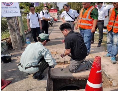
流量・水質調査機材設置
