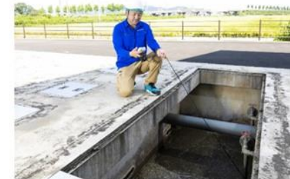
集落排水システム
