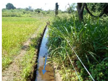
Left Bank canal of Kiulekada Ihara wewa
