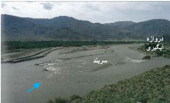
سرپند مایل با استفاده از سنگ دریایی بولدر در پروژه آبیاری PMS (بعد از مدل سازی سرپند Yamada با روش های سنتی جاپانی ساخته شده است)
