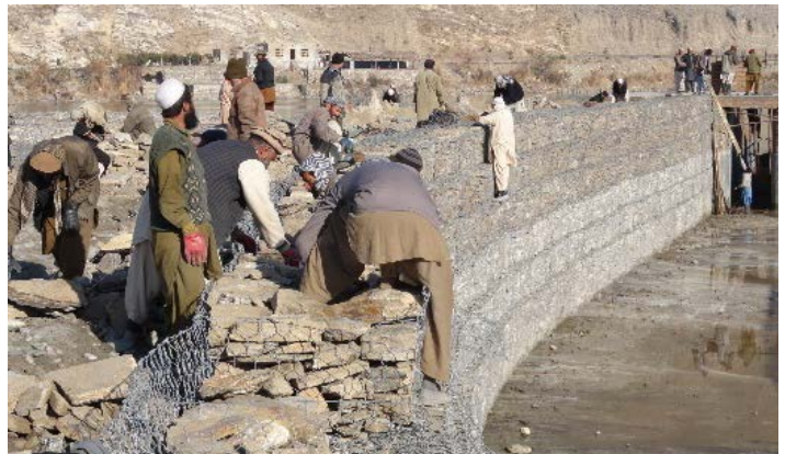
گابیون، که یکی از تکنیک های اساسی انجینری سیول پروژه آبیاری PMS است، در کنار کانال بکار گرفته شده است.
