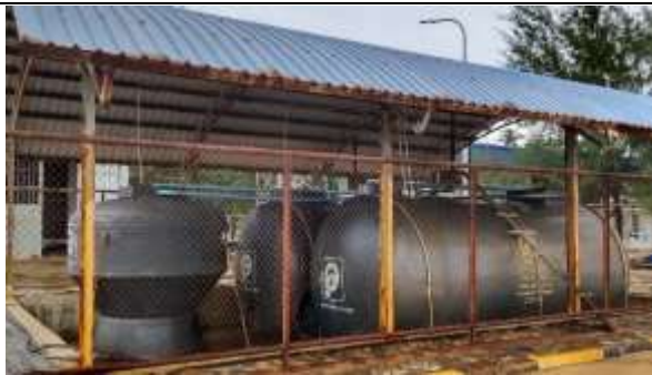
2022年7月21日 ケップの浄化槽の調査
