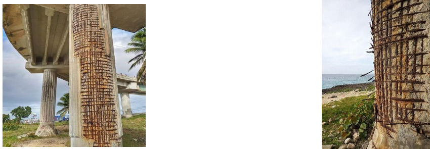
Figura 5-22 Deterioro del puente costero
