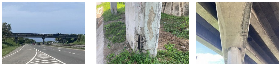
Figura 5-21 Puente sobre DR-3 (izquierda) y partes deterioradas (centro y derecha)
