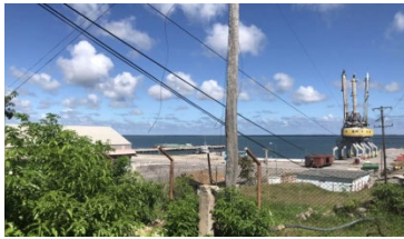
Vista del puerto
