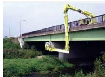
Ejemplo de inspección de puentes
