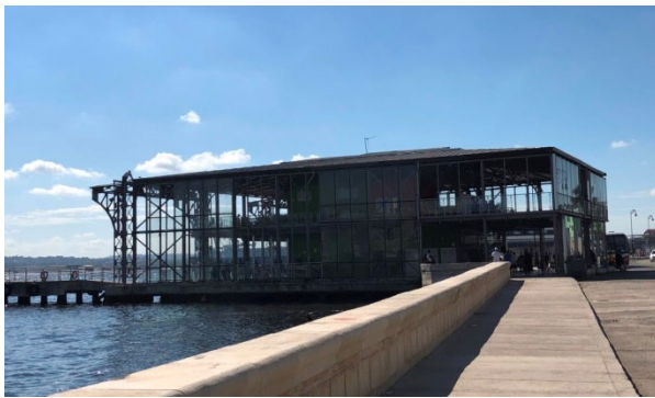
Terminal de pasajeros renovada (Muelle de Luz)
