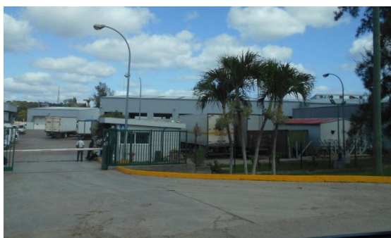
Instalaciones de mantenimiento automotor
