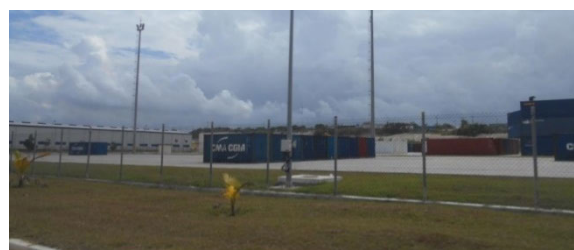
Depósito de contenedores
