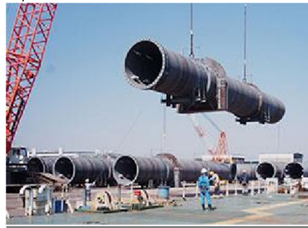
Tubería de agua para intercambiador de agua de mar
