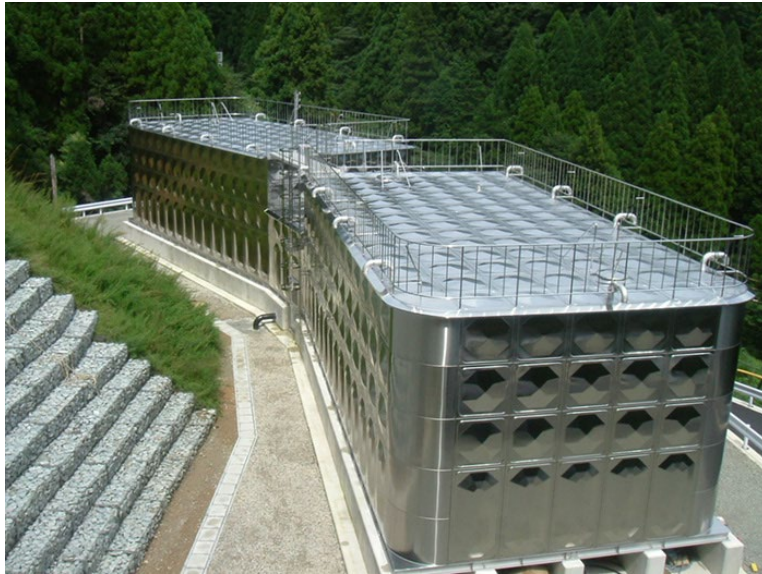
図 3 SUS 配水池 V=450\text{m}^3 2基 7.0 x 14.0x5mH
