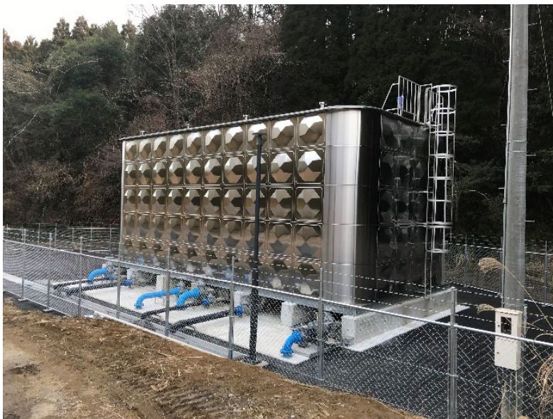
図 3 SUS 配水池 V=450\text{m}^3 2基 7.0 x 14.0x5mH
