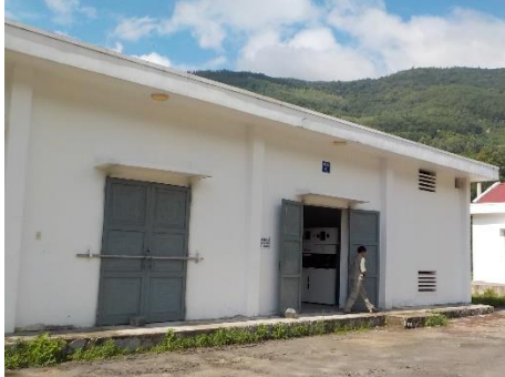
既設トンネル換気現況調査 (クモントンネル電気室)
