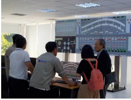
既設トンネル換気制御状況調査 (クモントンネルコントロールセンター)
