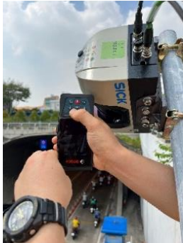
交通量計測機器設置 (サイゴン川トンネル坑口)
