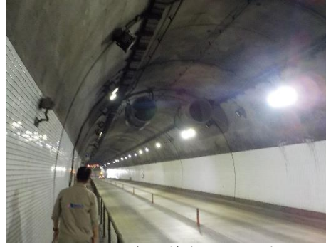
既設トンネル換気現況調査 (クモントンネル坑内)
