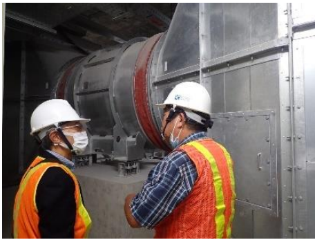
近隣 ODA 事業視察 (ホーチミン市地下鉄事業)
