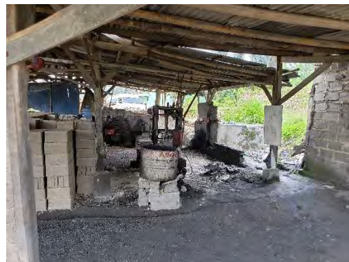
コンクリートブロック製造（手動式） 2019年12月12日
