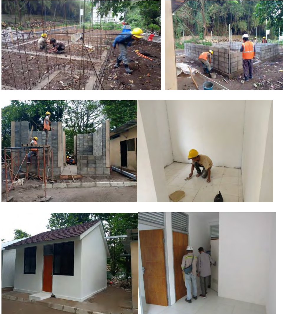
【写真 3-16 異形ブロック積層工法】
