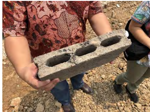
低所得層向け住宅施工現場（土ブロック） 2019年8月26日（自主渡航）
