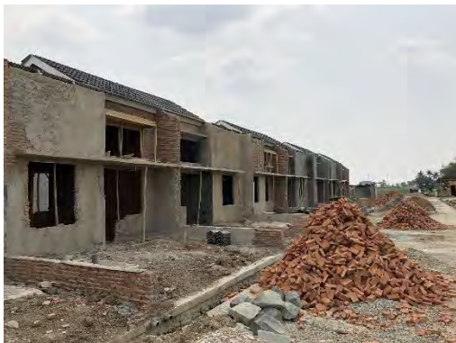
低所得層向け住宅施工現場 2019年8月26日（自主渡航）
