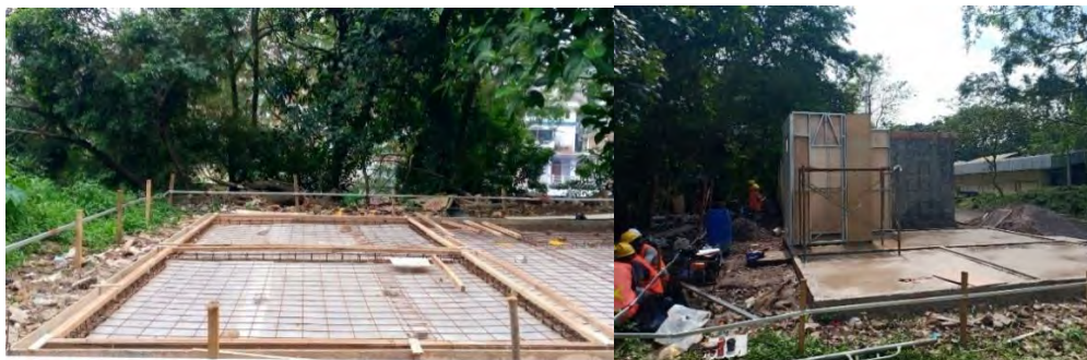
【写真 3-17 LGS 合板パネル工法】
