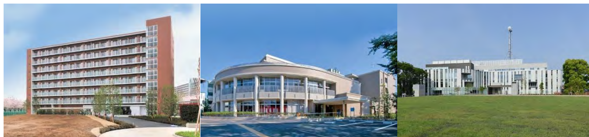
左：東京外国語大学学生寮 中：野洲市立野洲小学校 右：横浜市瀬谷区総合庁舎
