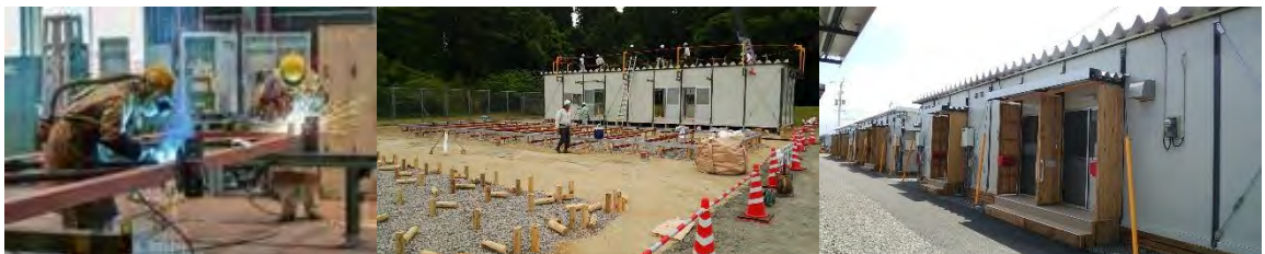
左：資材の工場生産 中：応急仮設住宅建設 右：応急仮設住宅
