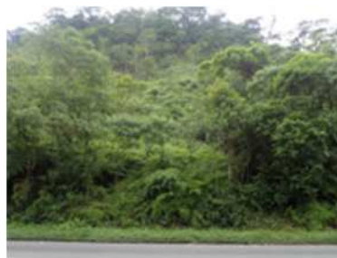
州道路斜面（地すべり箇所）
