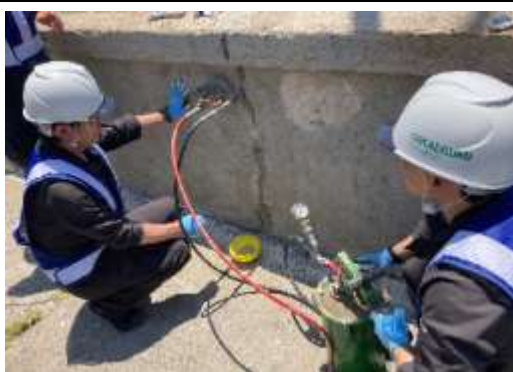
高架でのひび割れ補修デモンストレーション
