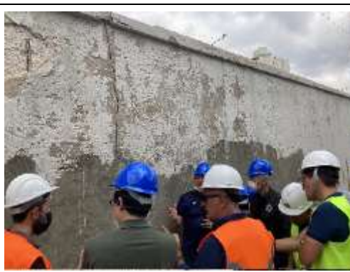
デモンストレーション現場（高架）の視察・協議
