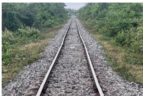
図 3-35 Battambang 付近の状態の悪い軌道
