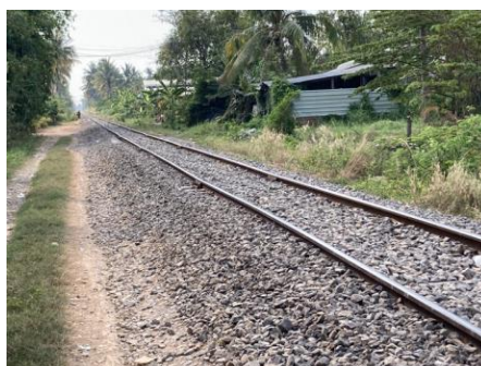
図 3-41 軌道が継目落ちとなっている区間例
