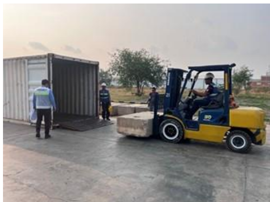
コンクリートブロックの積み込み
