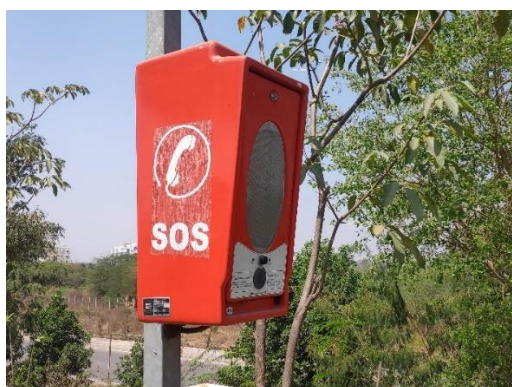
外環道路の緊急コールボックス
