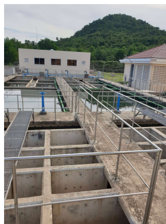
浄水場の沈殿池
