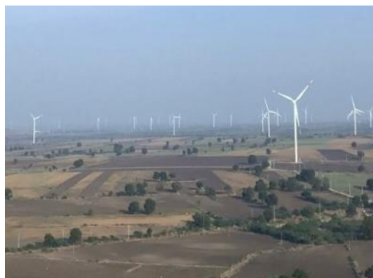
本事業で整備された風力発電設備 (出所：ACP 投資チーム提供資料)
