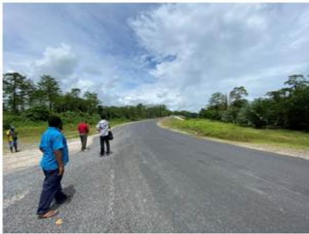
橋梁にかかる舗装済み取付道路 (カピウラ橋) (出所：外部評価者)
