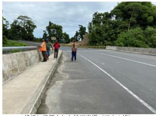
橋梁に設置された縁石歩道 (アウム橋) (出所：外部評価者)
