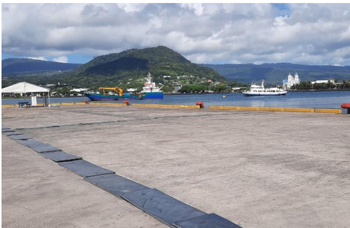
本事業で整備した新岸壁 (出所：現地調査補助員撮影)
