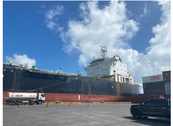
本事業で整備した新岸壁と接岸中の貨物船 (出所：外部評価者)
