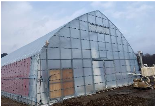
降雪地方向けのハウス（屋根が鋭い）
