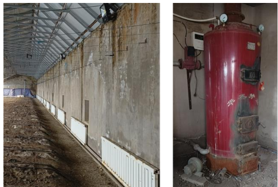
左：ラジエーター、右：ラジエーター用石炭ボイラー
