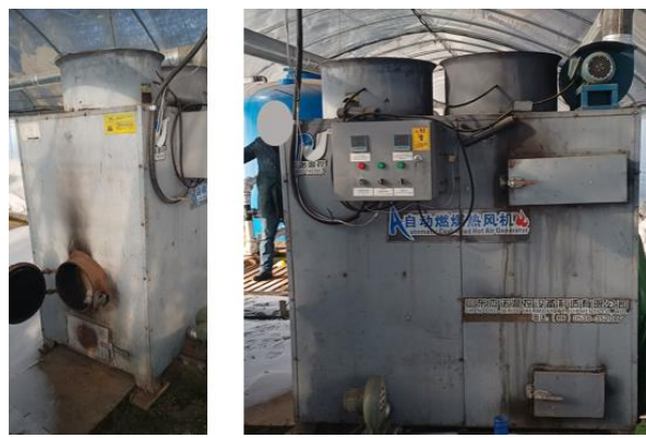
石炭燃料の暖房機（左：正面、右：側面）
