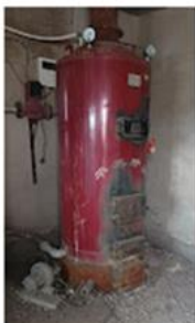
石炭燃料のボイラーとラジエーター
