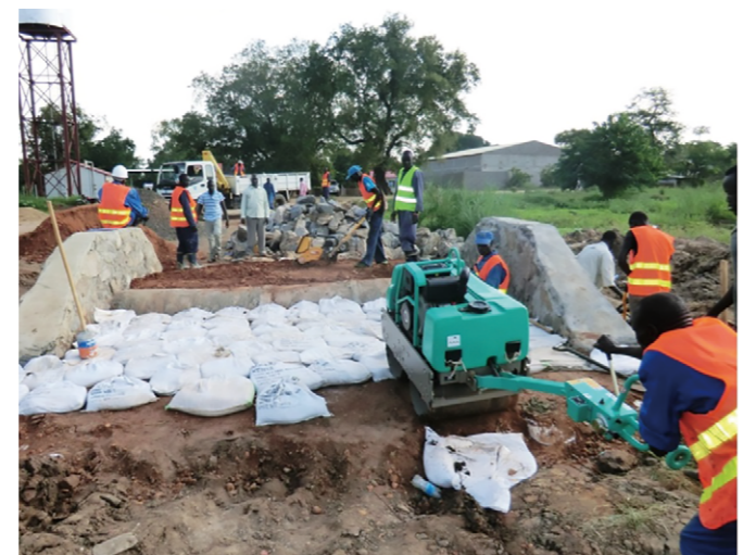
「ジュバ市持続的な道路維持管理能力強化プロジェクト」の土のうを使った修繕の実地研修（2013年9月）
