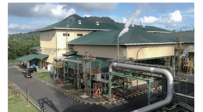
インドネシア・ラハドン地熱発電所(外観)
