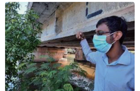
橋梁点検車を用いて点検された橋梁の1つ
