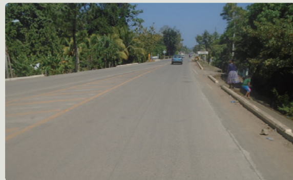
国道7号東線（第4工区）
