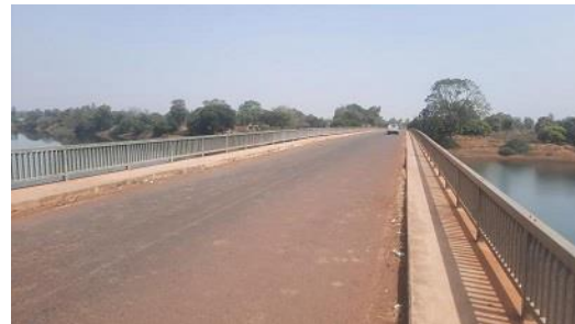
バフィン橋 (現地調査補助員撮影)
