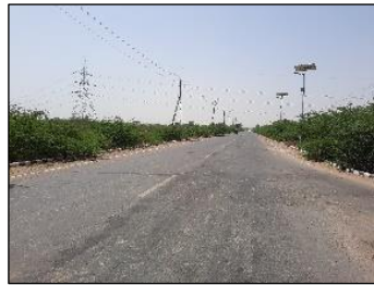
第3 サナンド工業団地(コーラジ工業団地)内の道路
