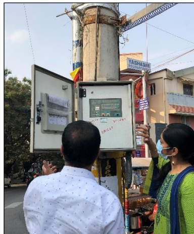
配電自動化対応区分開閉装置
