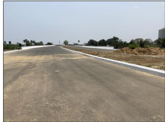
本事業で実施された小規模インフラ事業（バイパス道路建設）（出典：評価者）
