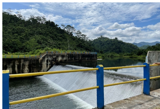
整備された堰堤（トンモ灌漑地区）
