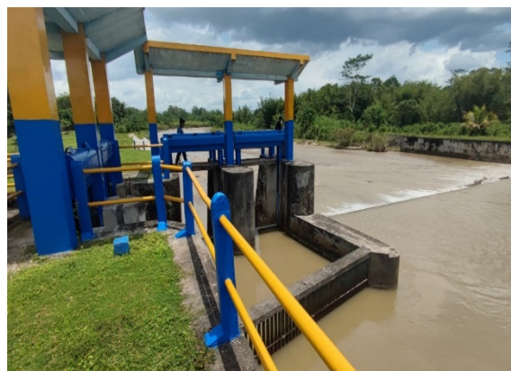
写真2：整備された取水堰 （ワイ・アプ灌漑地区）
