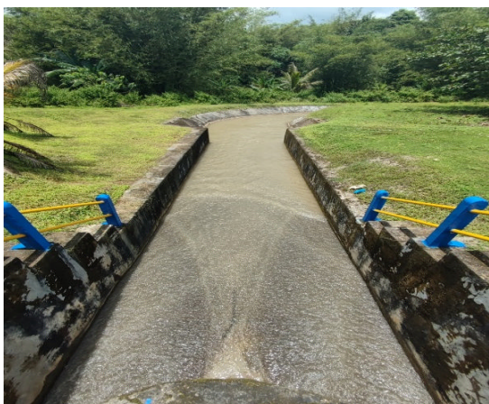
写真 6：取水堰からの分水箇所 （ワイ・アップ灌漑地区）
