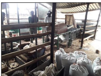
ヤトロファ・バイオ炭を利用したコンポスト生産施設
