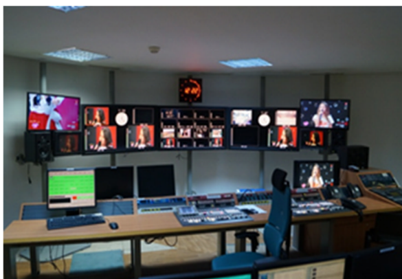
写真 3: TV チャンネル用マスター・コントロール・システム（出典：テレビ公社）
