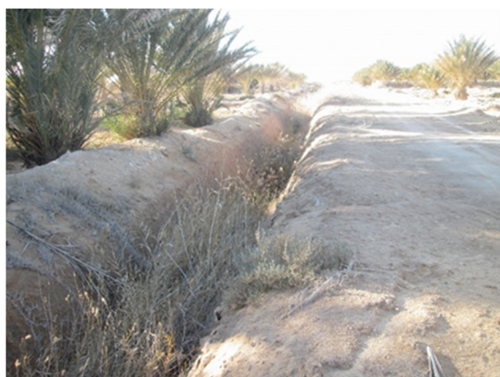
写真 1：整備された排水路 （ケビリ県 Tabaga）
