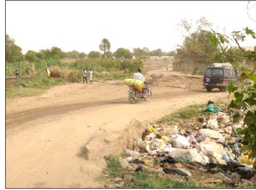
事後評価時にはゴミで埋まってしまい、道路は土砂流出で湾曲している （2022年2月）出所：評価者
