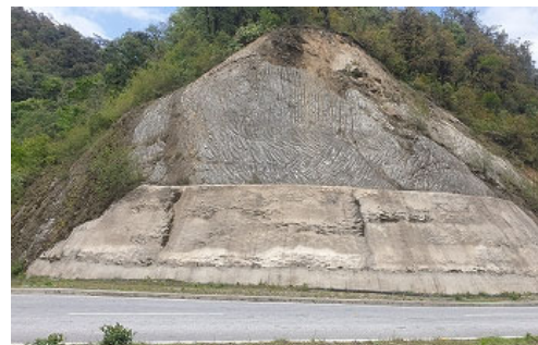
ザラムチュ橋取付け道路沿いの法面モルタル吹き付け
