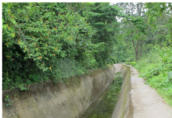
高位部幹線水路
