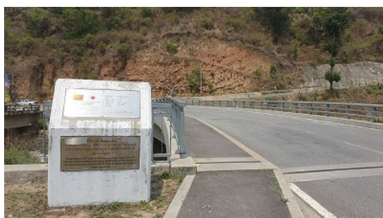
チュゾムサ橋の歩道
