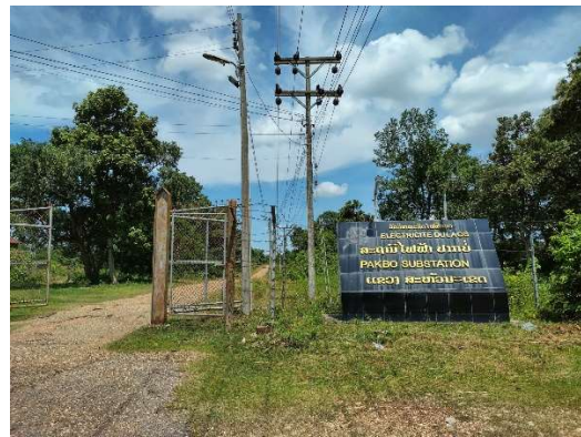
パクボ変電所（変電所敷地の入口）
