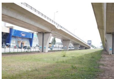
本事業で整備された跨道橋間の芝生
