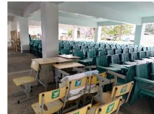
Use of piloti (San Roque)
