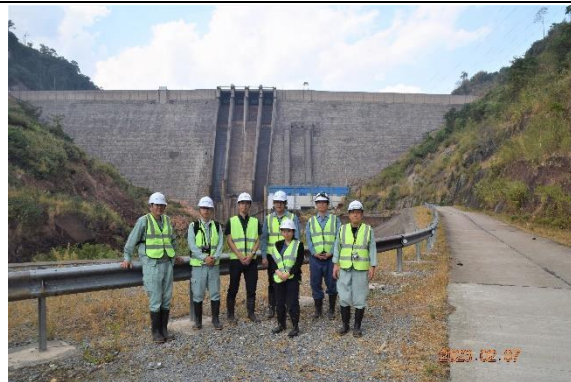
ナムニアップ 1(NNP1)水力視察状況
