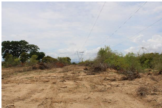
(Foto 11) Vista da rota da linha de distribuição (VII).
