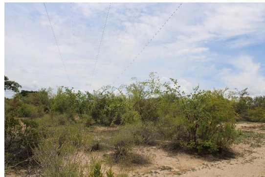
(Foto 12) Vista da rota da linha de distribuição (VIII).
