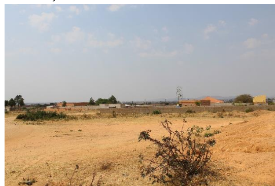
(Foto 4) Vista do lado oposto da subestação Arimba (II).
