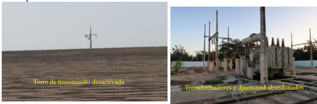
Figura 1.5-6 A situação actual da LT Namibe-Tombwa desactivada
