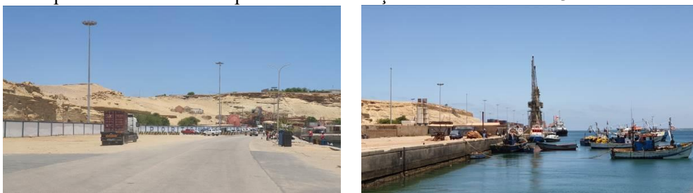
Figura 7.7-9 Imagens do Porto de Namibe
