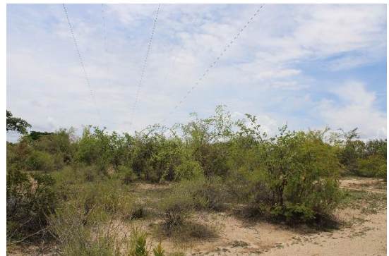
(写真12) 配電線ルートを望む (VIII).
