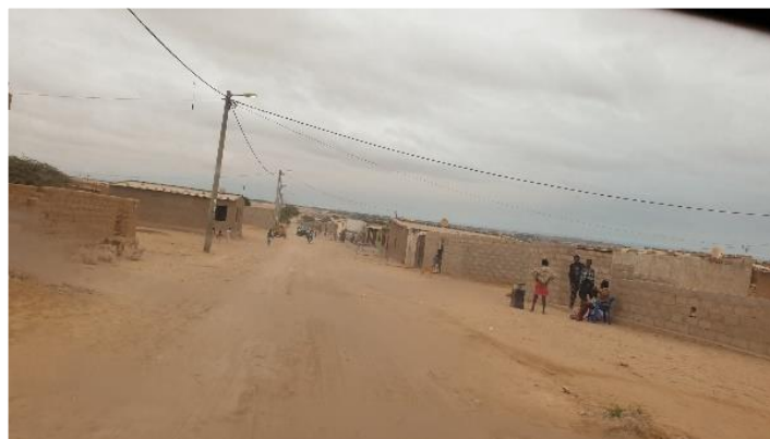
図 7.7-17 220/60kV 新ナミベ変電所への道路横断配電線の状況
