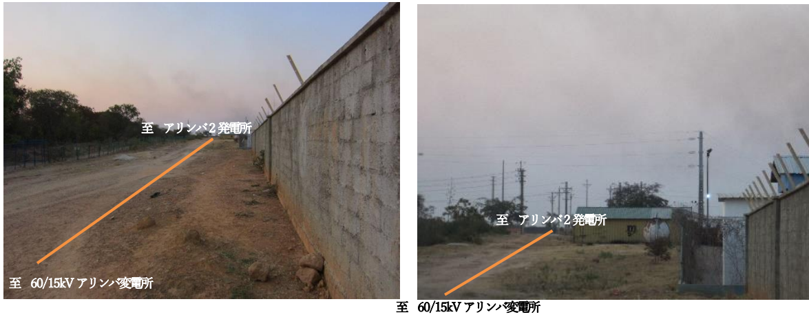
図 6.2-2 60kV 地中線ルートの実地状況(橙線が地中線ルート)
