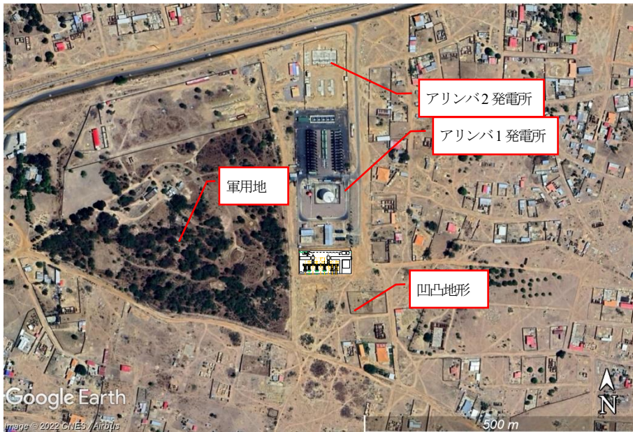
図 7.5.3 60/15kV アリンバ変電所周辺状況
