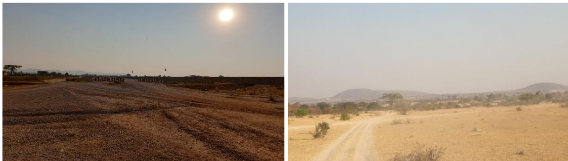
図 7.7-14 ルバンゴの補修が必要な舗装（左）・未舗装（右）の道路の状況
