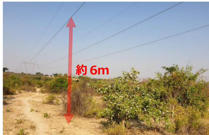
図 7.7-18 220/60kV 東ルバンゴ変電所への送電線高さ制限の状況
