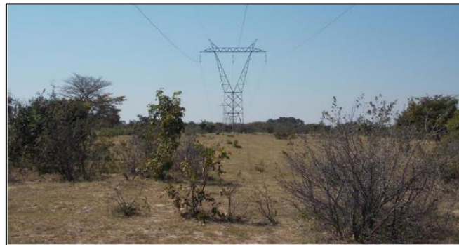
図 9.2-14 220/60kV 東ルバンゴ変電所予定地 (Poiares Muhaha 集落) の植生
