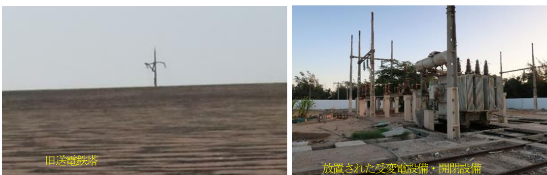
図 1.5-6 廃止されたナミベトンボア送電線の現状
