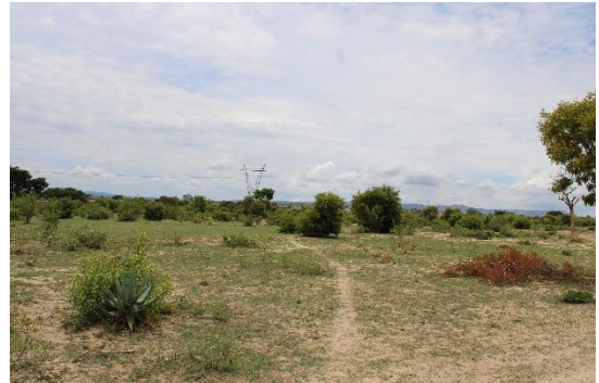
(写真14) 配電線ルートを望む (X).
