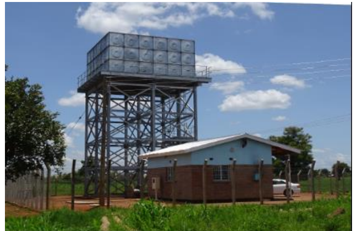
本事業で建設された高架水槽（カスング県サンテ地区）
