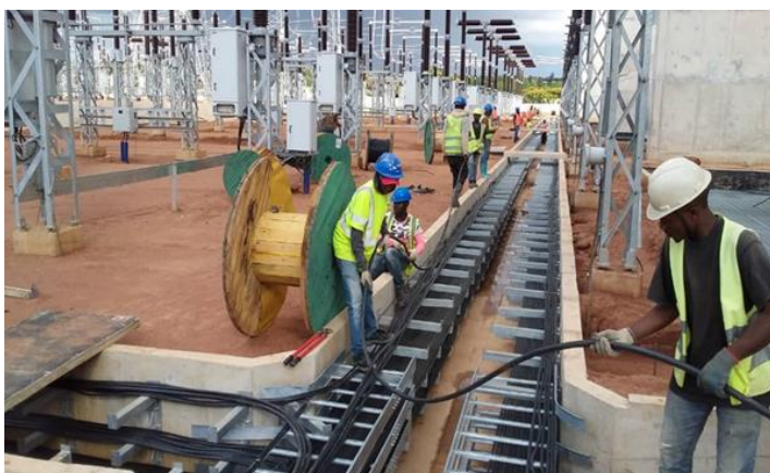
送電線敷設作業
