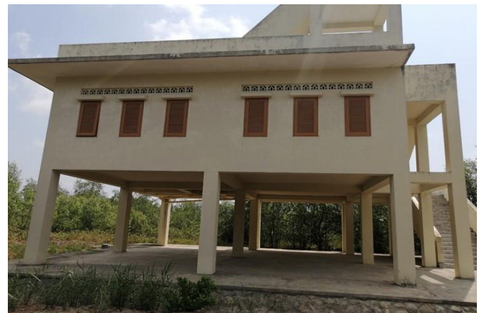
プロジェクトにて整備された森林監視タワーを併設したサイクロン避難施設
