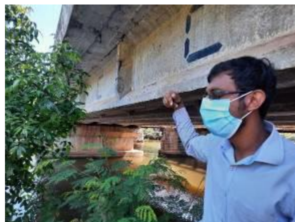
橋梁点検車を用いて点検された橋梁の1つ。
