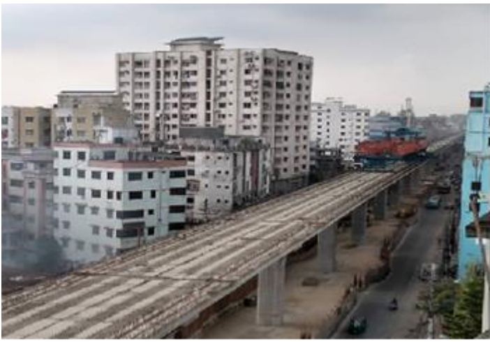
MRT6 号線の高架工事 カジパラ・ミルプール近郊
