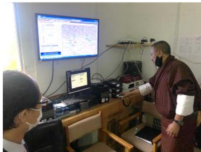
マンデ川流域の MHPA のダムコロニーに設置された 24 時間 365 日体制のコントロールルーム
