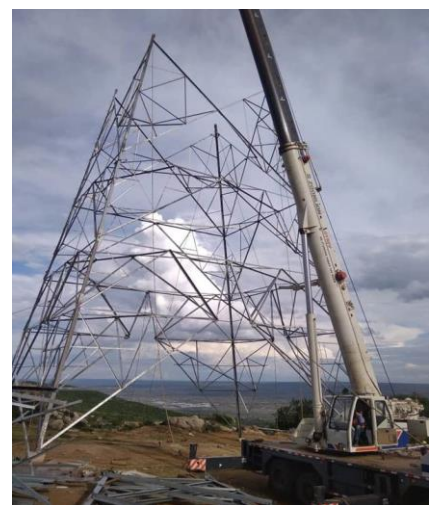
鉄塔建設作業
