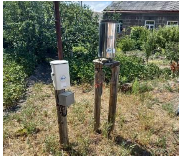
アラビにおいて、同様に良好に維持されている本事業で供与した転倒マス型雨量計
