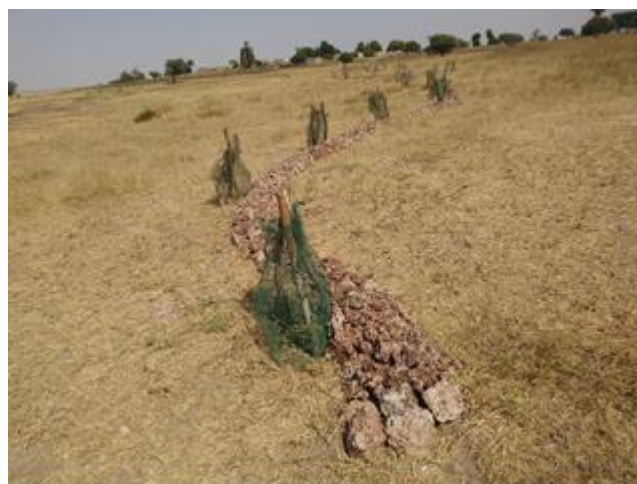
村人が維持管理している水食対策のための石列 ファティック州カマタンバンバラ村
