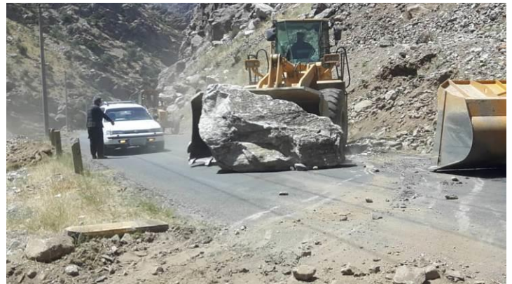
道路現場での日常保守が進行中
