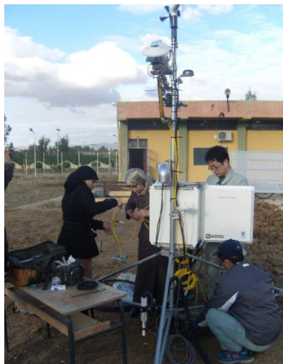
ソーラーパネルの設置
