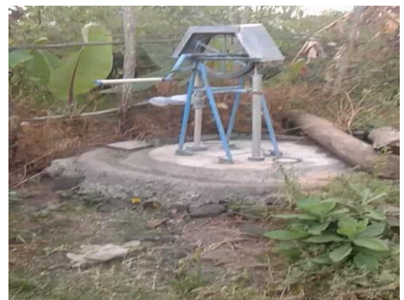
本事業完了後にマスカン郡に設置されたロープポンプ。 マイクロファイナンスを利用して購入・設置された。
