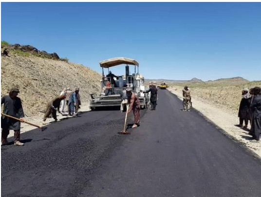
定期保守の一環としてのアスファルトでの舗装作業
