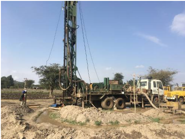
本事業の結果、提案・実施された準備調査（試験井掘削）
