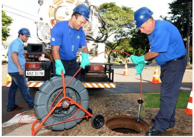
下水管路の診断
