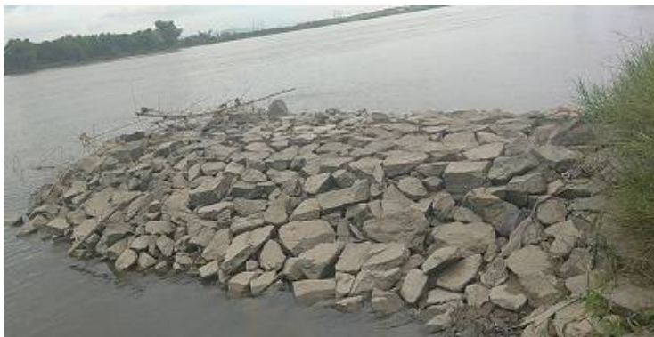
ハティン省における小規模河岸浸食対策工事
