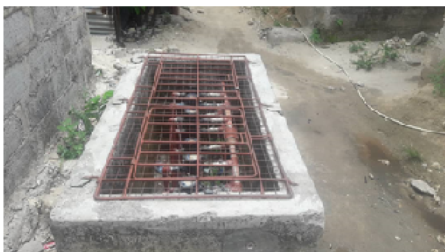
フェーズ 2 プロジェクトで導入された 10 世帯分の住宅接続水道メーターを示すマニホールド（マカダラ地区）
