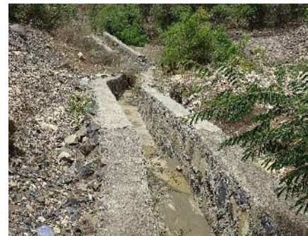
ERA により建設された側溝
