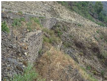
ERA により建設された擁壁
