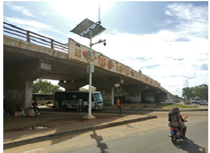
ティアロエ交差橋
