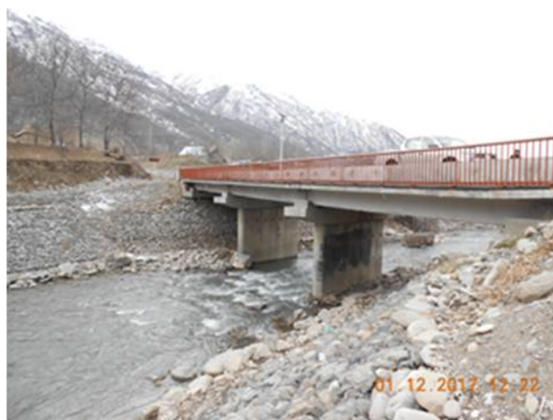
2016年修復後の橋梁 (Myrzake-Kara-Shoro)
