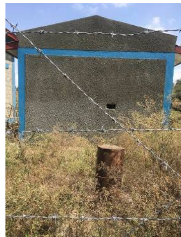
近隣のタウンへの給水に利用予定の本事業の試験井と USAID が建設した運転用建屋（後方）
