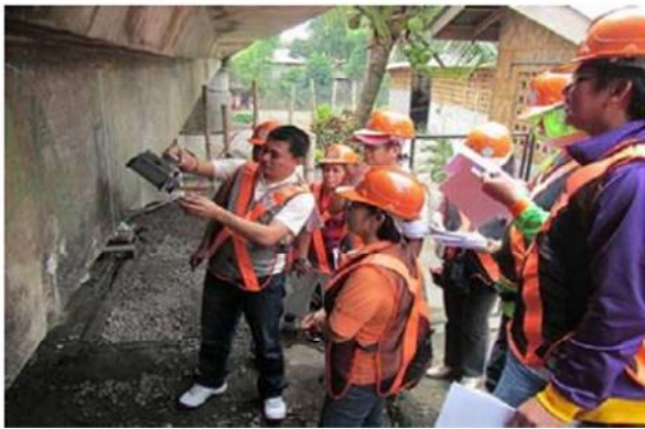
橋梁診断の様子
