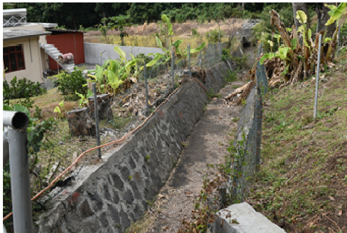
チトラクトでの対策工事は適切に行われ、 地域住民を危険から守っている
