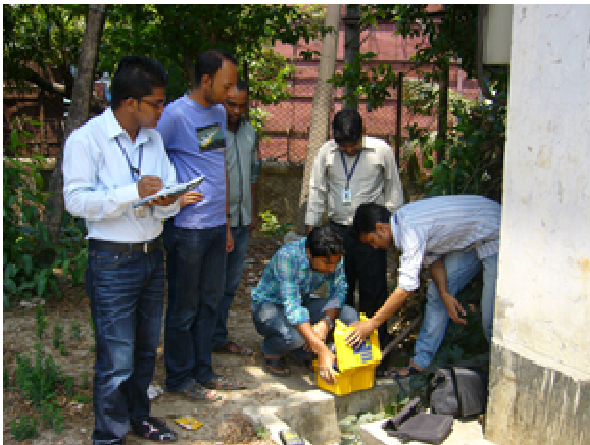
携帯超音波流量計による漏水調査
