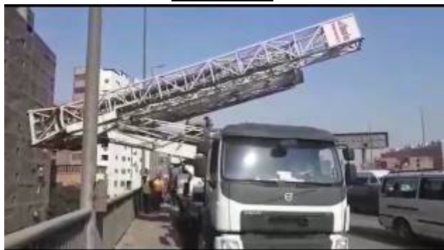
橋梁点検車両
