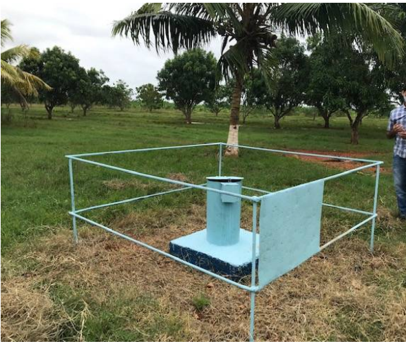
稼働中の JICA 井戸 1 号 (アルテミサ県)
