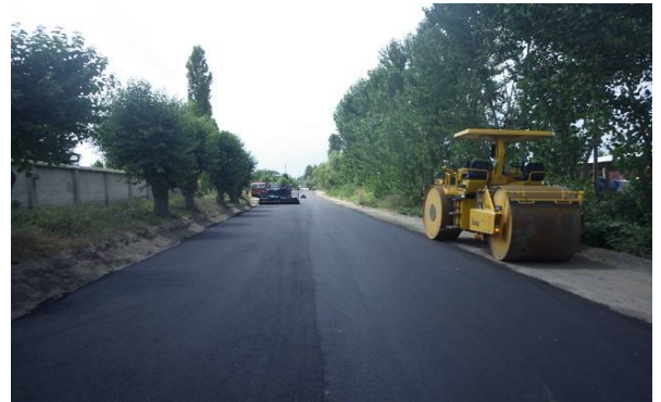
ヒッサール SETM 傘下のルダキ SEHM が 2017 年に改訂ガイドラインを用いて行ったホットミックスアスファルトによるドゥシャンベ・アユニ道路(国道)の補修
