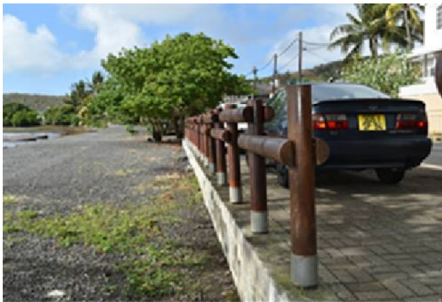
グラン・サブルにて、海岸保全の一部として建設された、地域住民のためのレクリエーション、緑地、駐車場、安全柵
