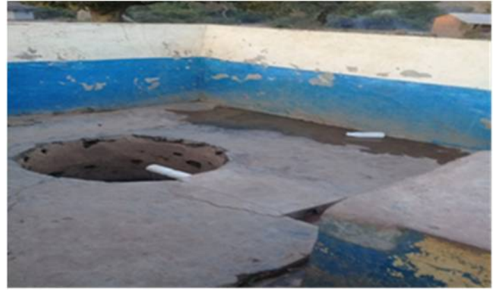
モロシヨ給水施設では、水料金徴収、研修が行われ、適切な衛生状態が維持されている。
