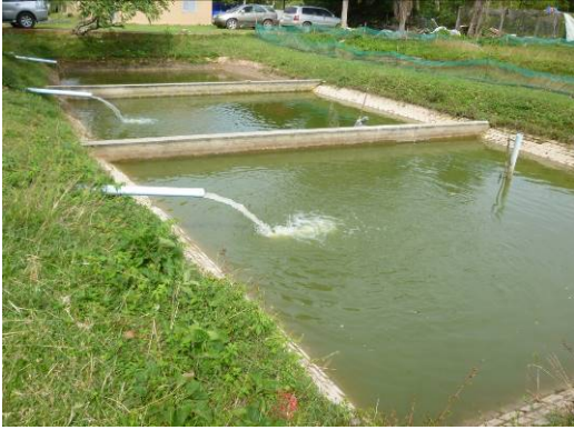
本事業で調達したポンプにより給水中のタクビル種苗生産ステーションの養殖池
