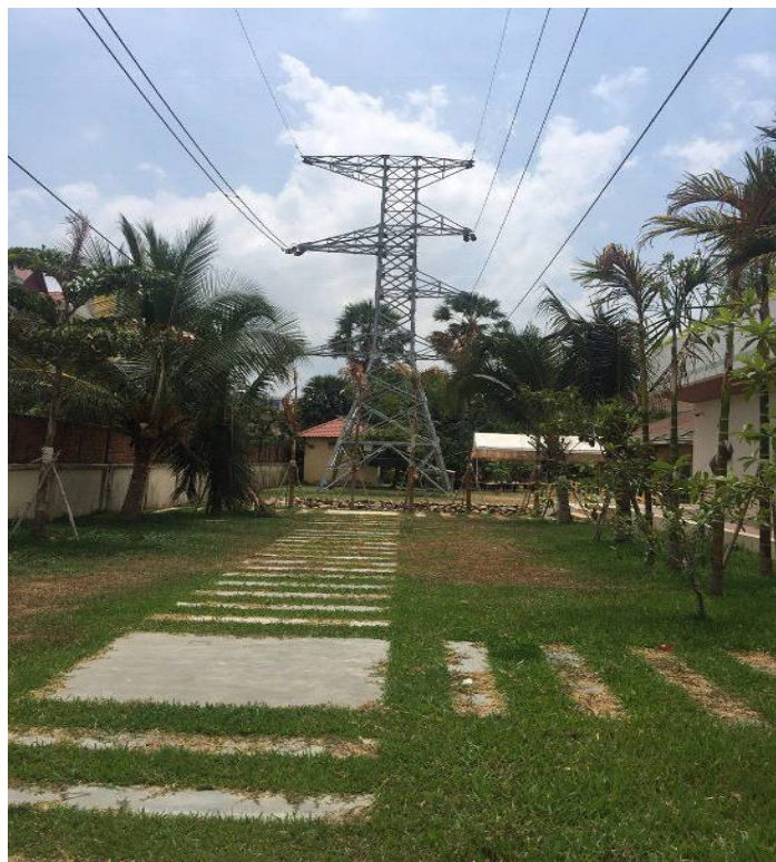
電力大学に設置されている訓練塔
