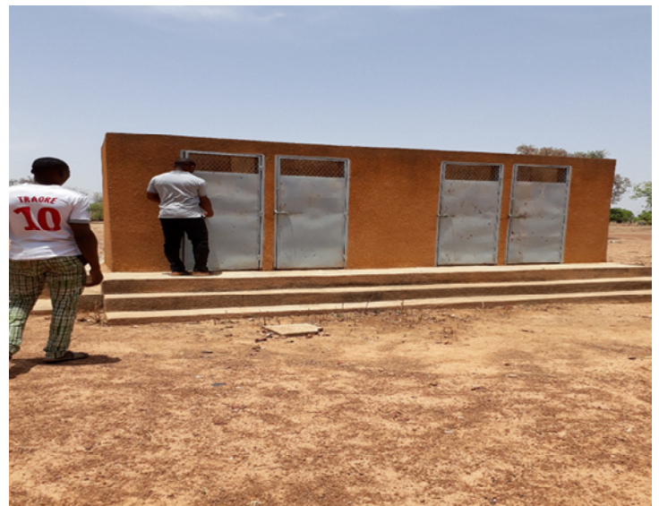
アンデムテンガ I 基礎教育地区のレルコム小学校のトイレ
