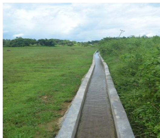
技術協力プロジェクトでの水路修復 （事業実施後）
