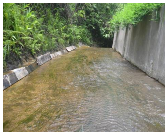
技術協力プロジェクトでの頭首工（放水路）建設 （事業実施後）
