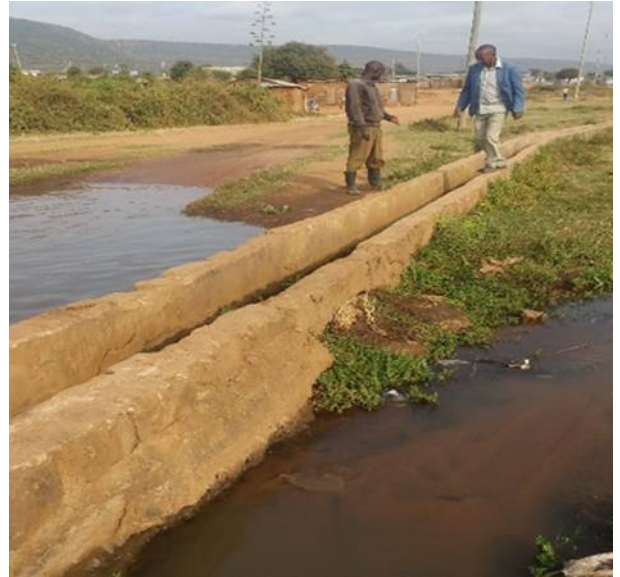
カヌンカ B スキームの会員により建設された灌漑水路
