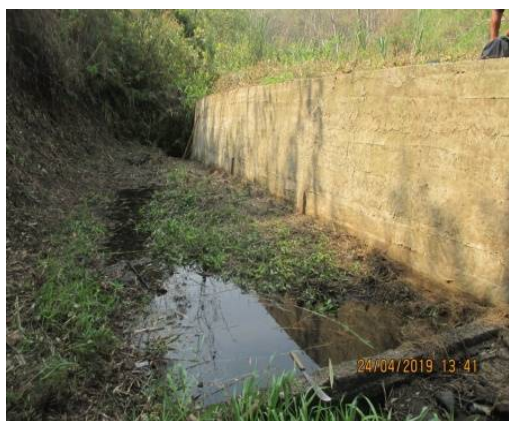
技術協力プロジェクトでの頭首工（放水路）建設 （事業実施前）
