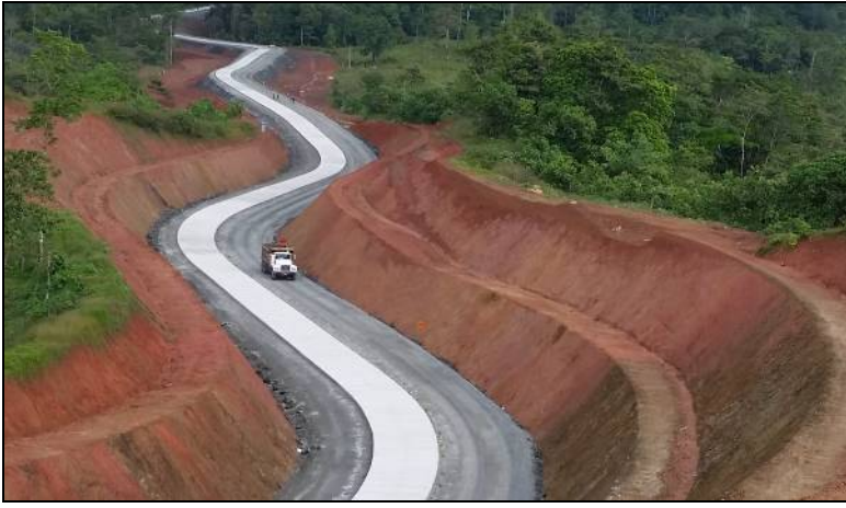
ヌエバ・ギネアーブルーフィールズ道路建設（135.7 km）
