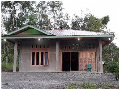
西ニアス州でフェーズ 2 の元研修員が建設した耐震住宅
