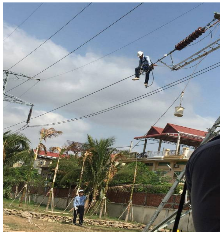
送電線維持管理：第2フェーズ（2019年）のもとで実施された技能競技会
