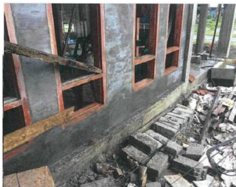
ニアス県において、基礎が完成した耐震ノンエンジニアド住宅
