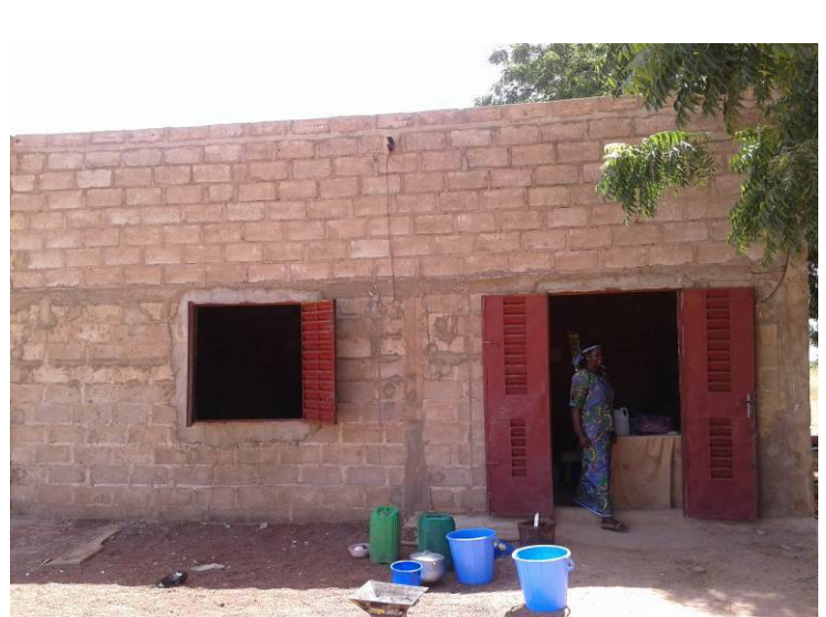
学校運営委員会により建設されたナムサの小学校の教室と先生
