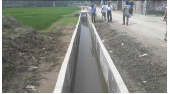
ロングプール市排水路改善 (RCC)
