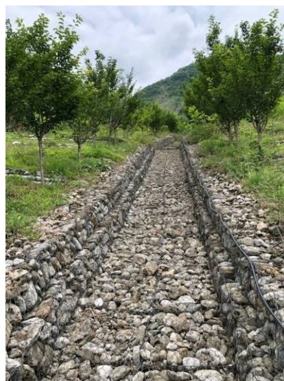
本事業の技術を使用した北川県の独自施工地 (施工時期は事業実施中)
