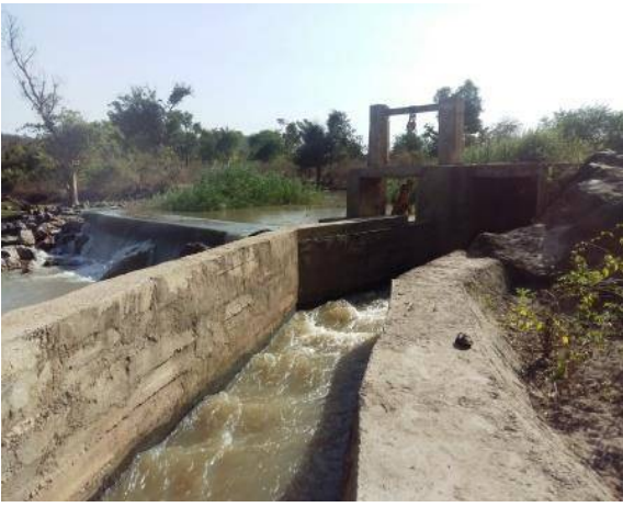
本事業で建設されたソキド小規模灌漑の幹線水路
