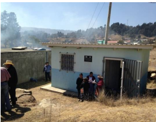
地下水給水施設
