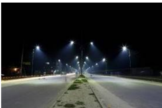
チッタゴン空港道路の改善（ChCC）
