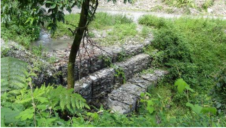
カスキ郡ディタールにおける道路保護のための土壌浸食対策
