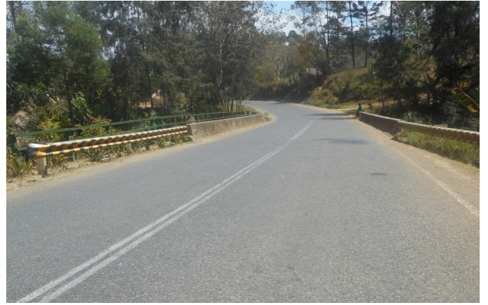
オロンバカ橋の二車線道路
