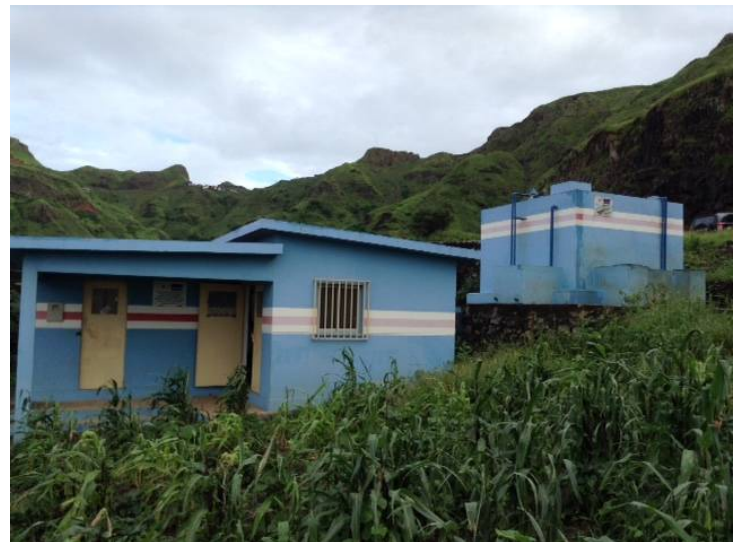
レバダ（サン・ロレンソ・ドス・オルガオス）の給水タンク及び機械室
