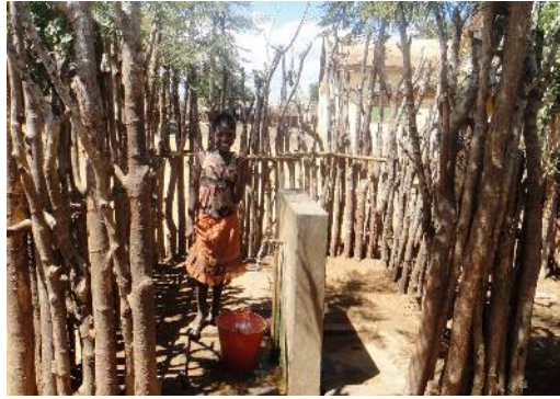
ポンプ給水システムに接続された給水所から水汲みをする利用者
