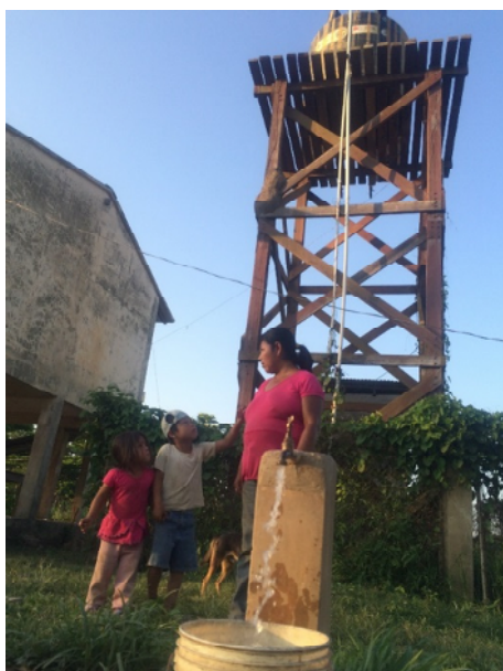
(ベニ県のプエルト・ヘラルダ村落の太陽光パネルを供えた給水施設)
