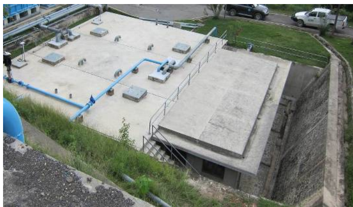
ベモス浄水場下部配水池
