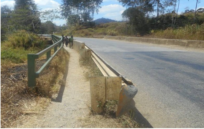
オフィガ橋の手すり付き歩道
