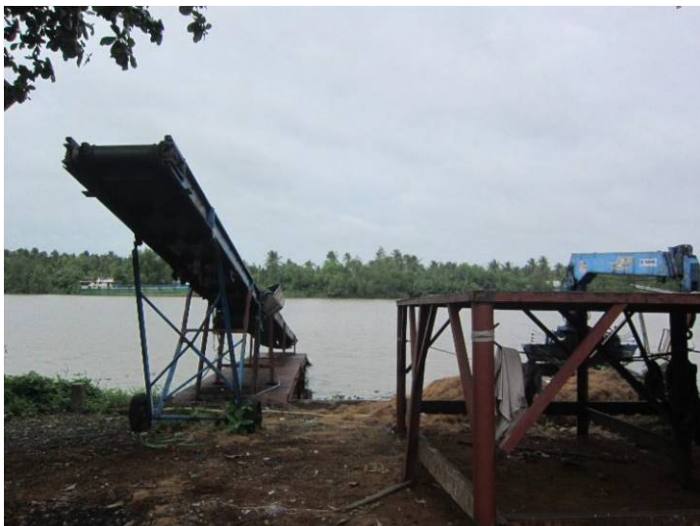
ベンチェ省塩水侵入対策防潮水門建設予定現場
