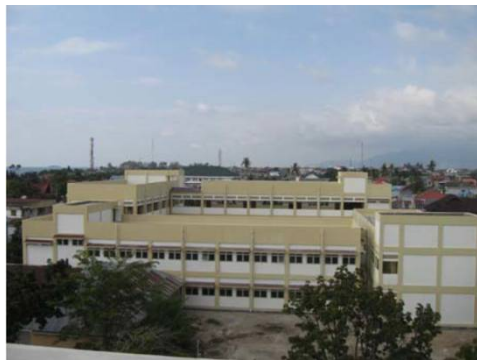
工事完了時（2012年1月）
