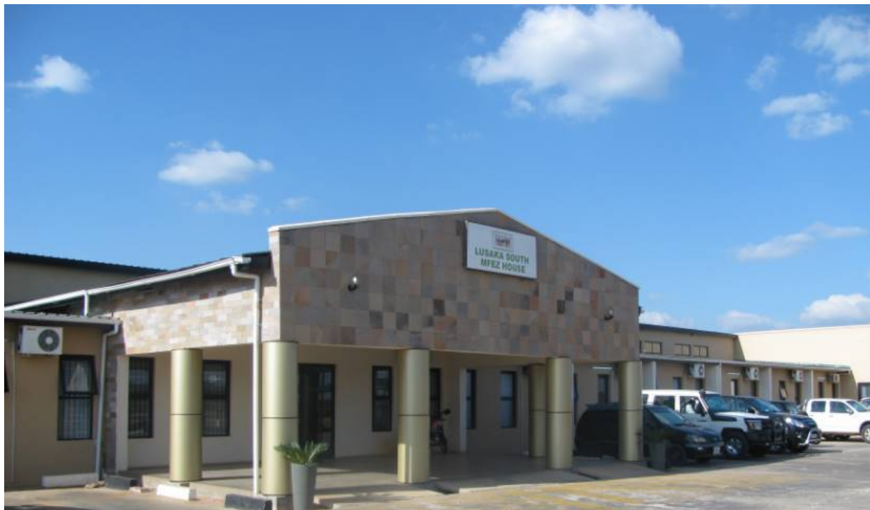
ルサカ南部マルチファシリティ経済区オフィスビル
