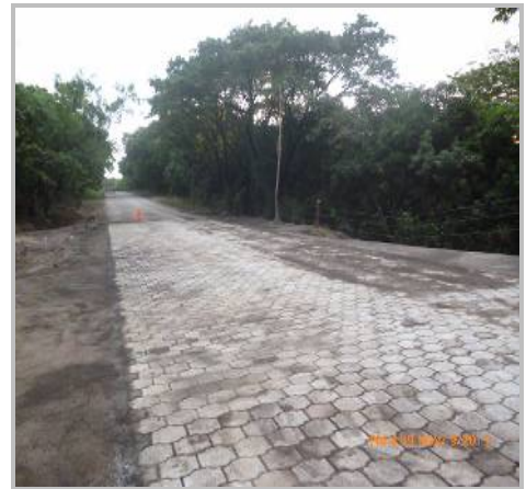
(雨季の降雨による被害を受けた後に補修された道路)
