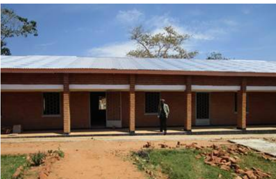
(Nkhata Bay 県の DEP プロジェクトで建設された Kalambwe 小学校の 2 つの教室)
