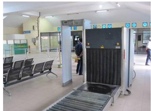
故障しているドゥマイ港 X 線検査装置、門型金属探知機
