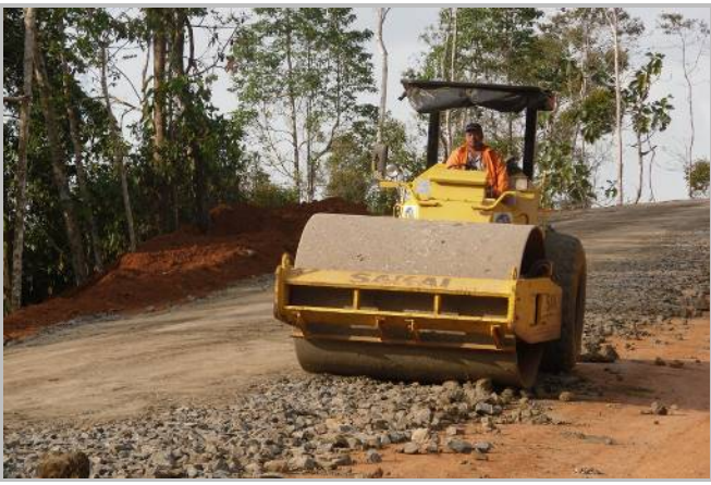
(調達器材を用いた道路改修の様子)
