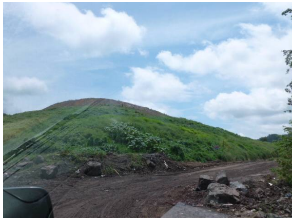
他の処分場（火事発生後、使用停止）
