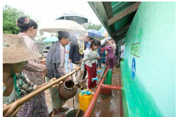
村落給水施設
