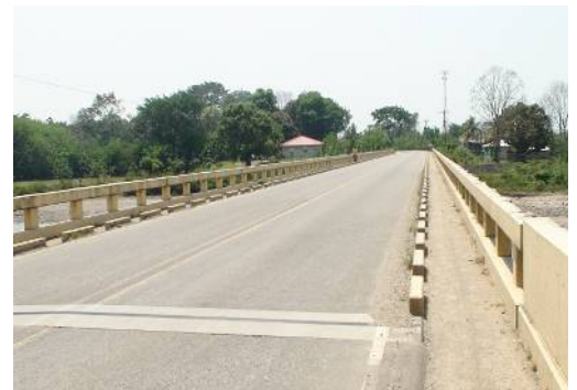
上部工(北部側から)
