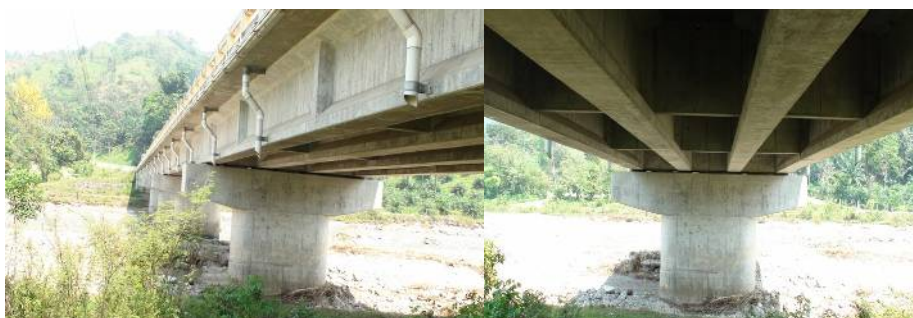
上部工(橋脚、橋台：プログレス市側から)
