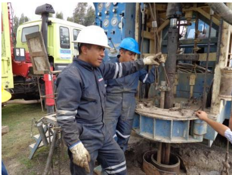
井戸掘削現場で指示を出す技術者
