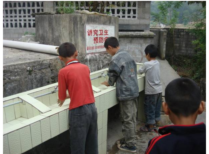
サブプロジェクトで作られた小学校の手洗場
