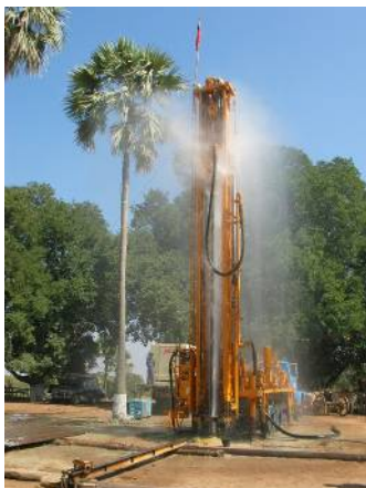
深井戸掘削作業
