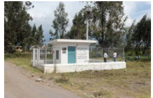
本事業にて建設された井戸建屋
