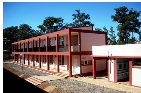
本事業で整備された宿舎
