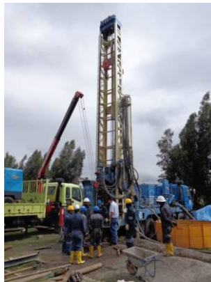
本事業にて調達された掘削機
