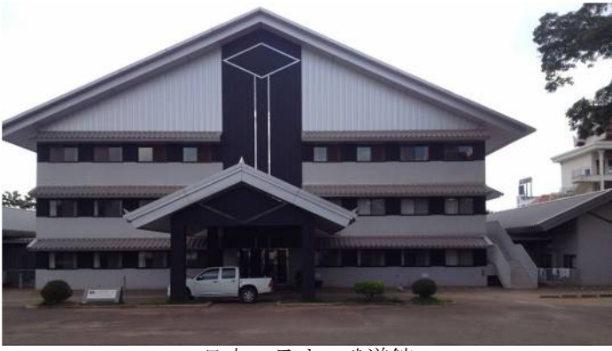
日本・ラオス武道館
