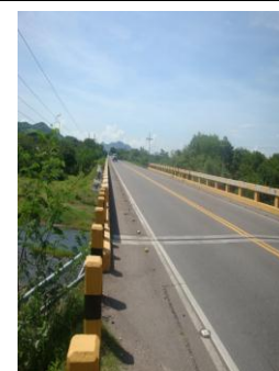
Puente Agua Caliente
