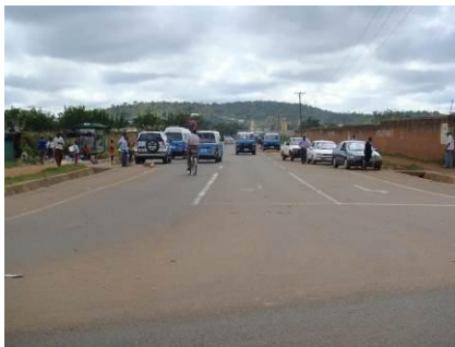
バウレニ道路。沿道にはコミュニティ・マーケットと学校がある。道路は公共バス路線としても効果的に利用されている（写真の青いミニバス）。維持管理状況は概ね良好である。
