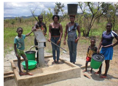
供与された機材で整備された深井戸と利用者
