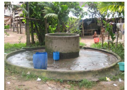
建設された井戸付近の浅井戸は、洗濯、水浴びのみに使用されるようになった。
