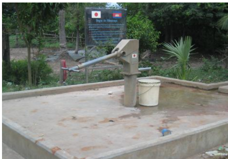
建設された深井戸は住民により適切に維持管理され、良好な状態。年間を通じて枯れることもない。
