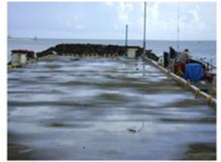
（高潮対策として）プロジェクト期間中に建設された護岸
