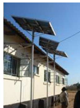
ソーラー式冷蔵庫用のソーラーパネル
