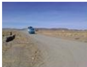
本事業で整備された機材を用いて整備された道路。道路整備により、交通量は約 2 倍になった。
