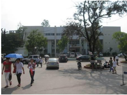
ホアビン総合病院技術棟
