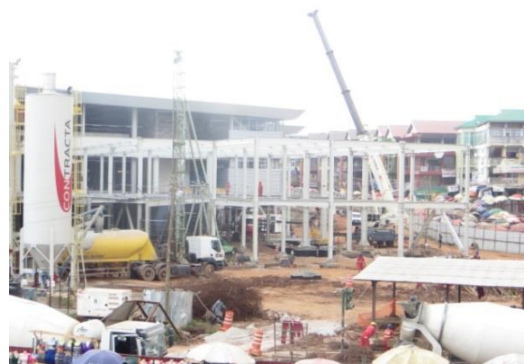
ケジアターミナル・コンプレックス建設現場
