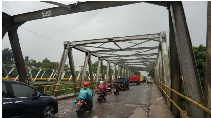
橋梁メンテナンスのパイロットサイト
