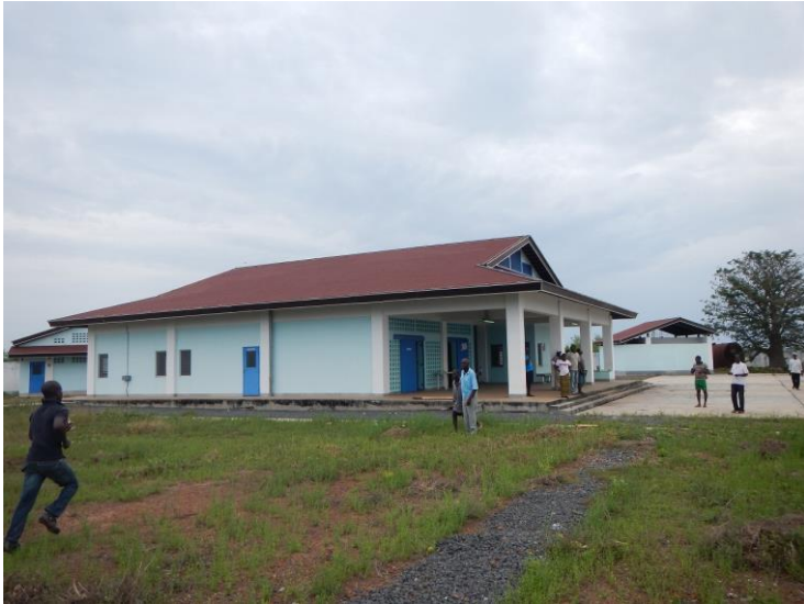
カシーン管理棟
