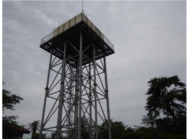
カシーン高架水槽
